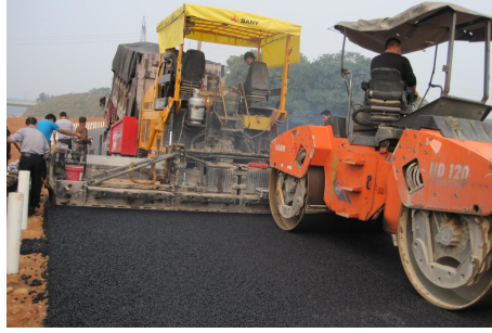
图 2.6-5 压路机紧跟摊铺机碾压
