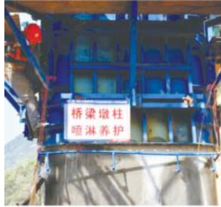
图 3.3.4 高墩喷淋养护
