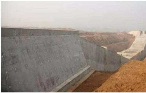
图 1.5-19 重力式挡土墙
