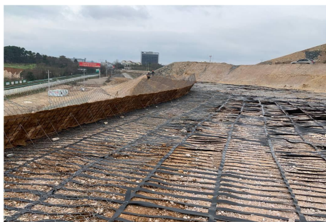
图 1.8-23 绿色加筋面墙及筋材安装
