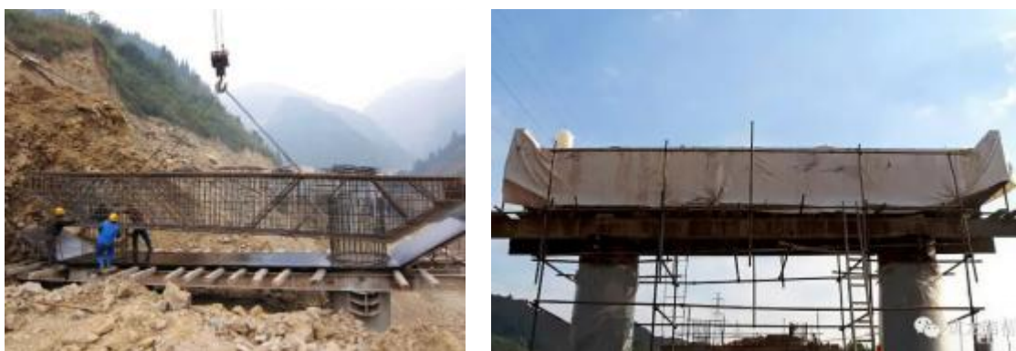
图 3.3.5 盖梁施工
