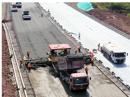
图 2.4-3 大宽度大功率抗离析摊铺机摊铺
