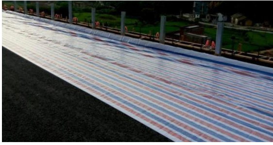
图 2.6-7 土路肩和护栏施工时的防污染措施
