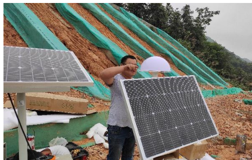
图 1.8-5 太阳能充电板安装
