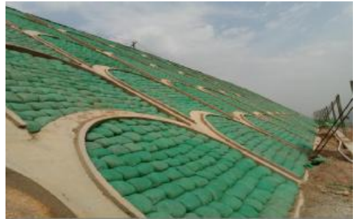
图 1.5-10 路堤植生袋边坡防护
