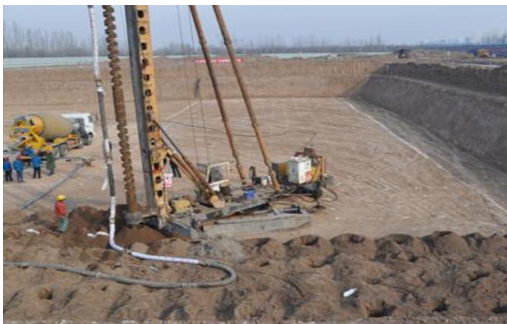
图 1.4-7 CFG 桩施工
