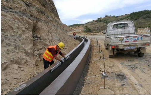
图 1.6-1 路基边沟施工
