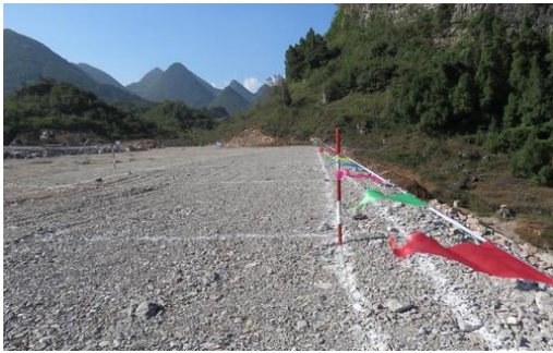
图 1.3-11 填石路基填筑施工
