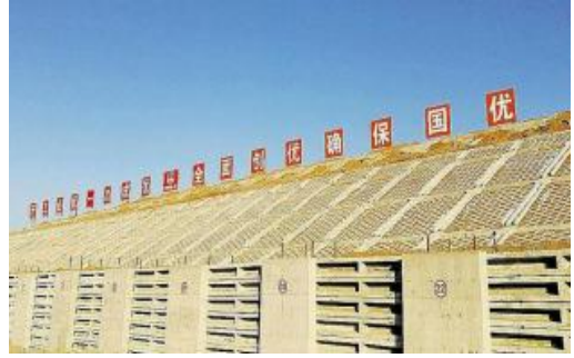
图 1.5-12 路堤挂板式桩板墙
