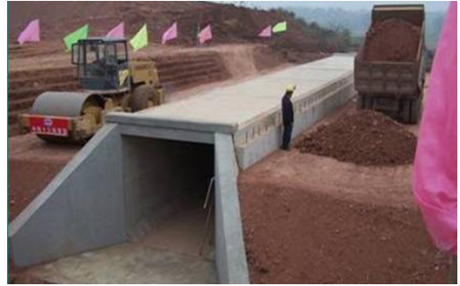
图 1.3-16 台背回填施工现场
