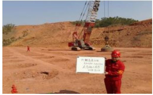
图 1.4-2 路基强夯施工现场记录
