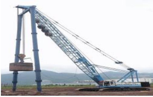
图 1.4-1 路基强夯施工机械
