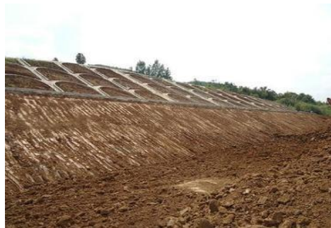
图 1.3-2 土质路堑开挖施工后
