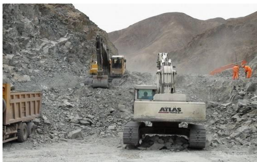
图 1.3-3 石质路堑开挖局部
