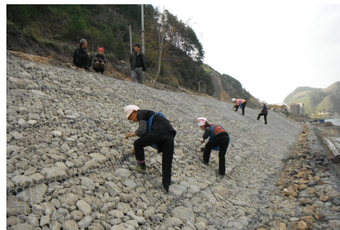
图 1.8-37 雷诺护垫现场效果
