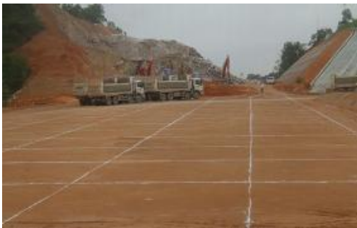
图 1.3-7 填土路基填筑施工
