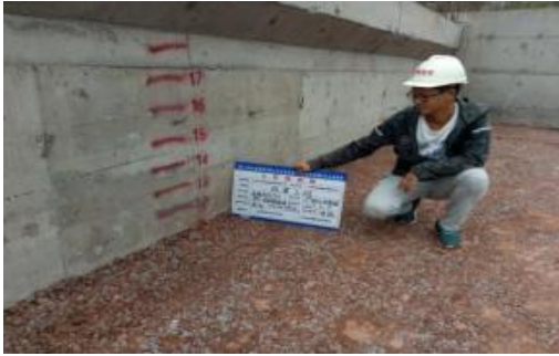
图 1.3-15 台背回填施工记录
