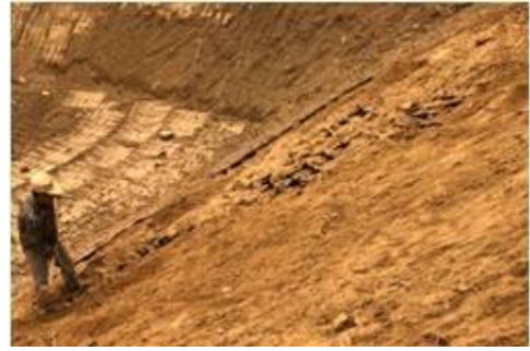
图 1.8-20 人工整理坡面
