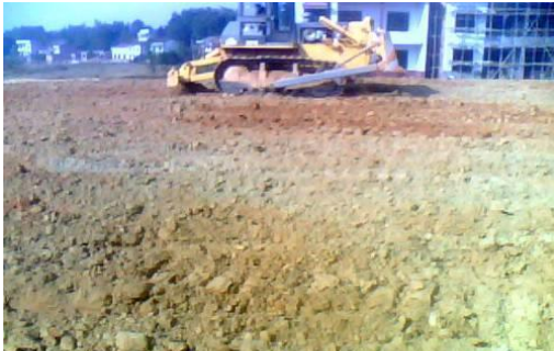
图 1.4-15 全风化花岗岩路堤翻晒
