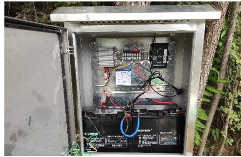
图 1.8-13 压差式静力水准仪安装（二）
