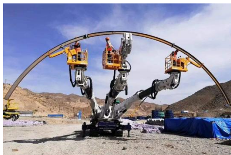
4.6-13 多功能拱架安装机
