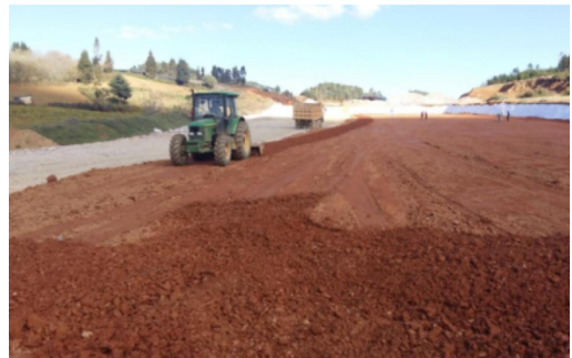
图 1.4-14 红黏土路堤填筑施工
