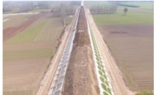
图 1.4-12 路基堆载预压过程
