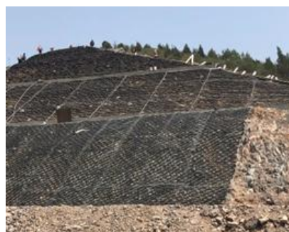
图 1.8-18 定角式格室坡面敷设
