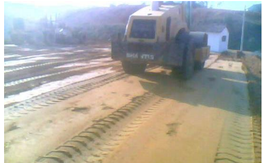
图 1.4-16 全风化花岗岩路堤碾压
