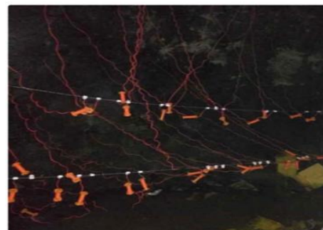
4.11-4 数码电子雷管施工现场
