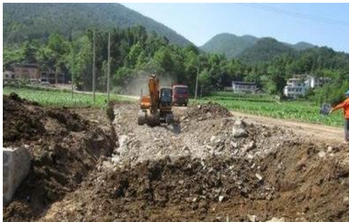
图 1.4-3 浅层换填施工
