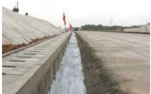
图 1.6-5 路基渗沟、盲沟施工后
