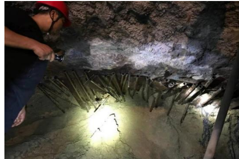
4.11-16 窄翼超前小导管施工
