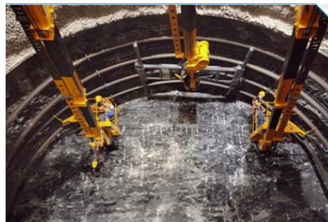
4.6-14 拱架安装机现场拼装
