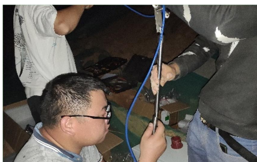
图 1.8-6 固定测斜仪安装
