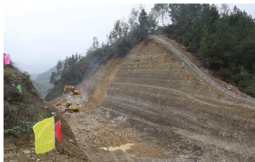
图 1.3-4 石质路堑开挖全貌
