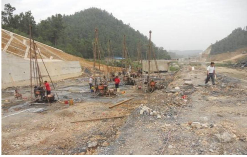
图 1.4-17 岩溶路基钻孔
