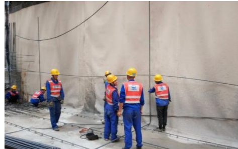
4.11-12 防水卷材施工
