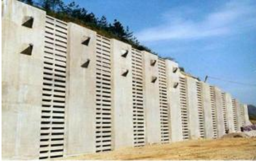
图 1.5-11 路堑挂板式桩板墙
