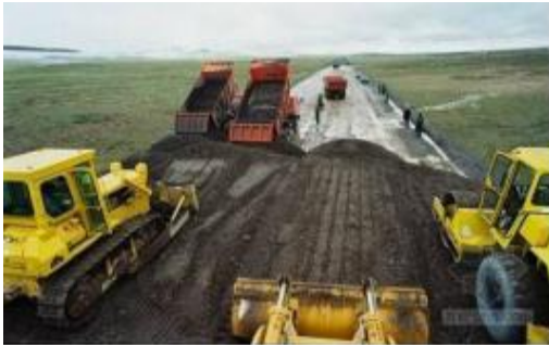
图 1.4-11 路基堆载预压施工
