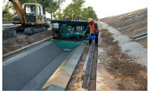
图 1.6-2 路基排水沟施工
