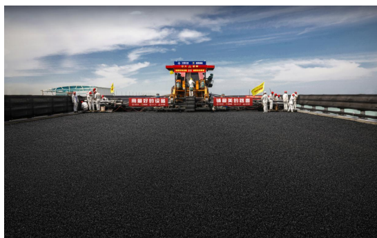
图 2.10-3 整体摊铺提升路面均匀度、密实度、平整度
