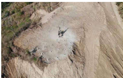
图 1.3-5 石质路堑爆破开挖前
