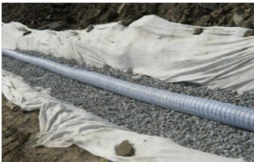
图 1.6-4 路基渗沟、盲沟施工前
