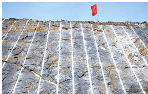
图 1.3-6 石质路堑爆破开挖后
