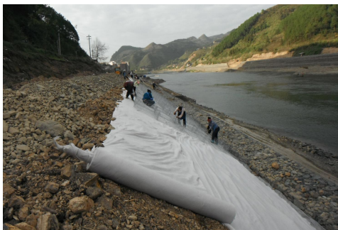
图 1.8-36 雷诺护垫施工现场
