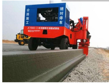
图 2.8-2 滑模施工路缘石
