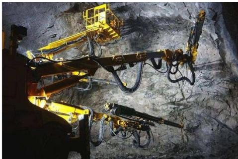
4.5-5 多臂凿岩台车施工
