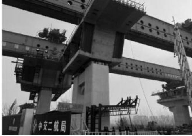
图 3.8.4 标准节段架桥机悬臂拼装
