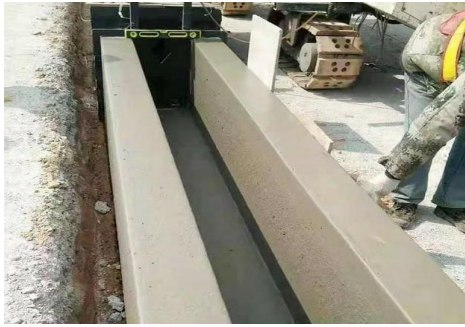
图 2.8-1 滑模施工排水沟
