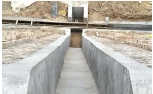
图 1.6-4 路基急流槽
