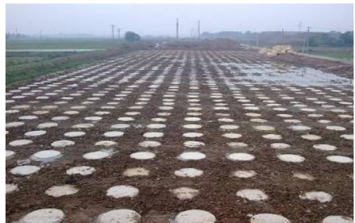
图 1.4-8 CFG 桩成桩
