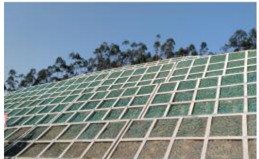
图 1.5-2 锚杆框格梁骨架护坡
