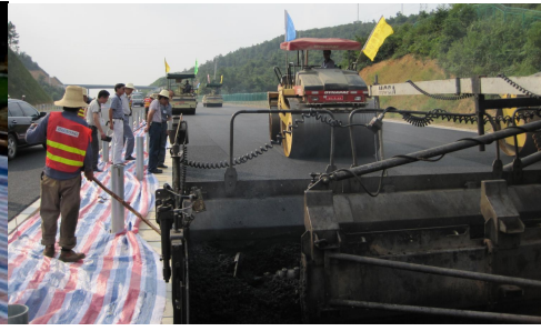
图 2.6-8 采用彩条布覆盖中分带防污染
