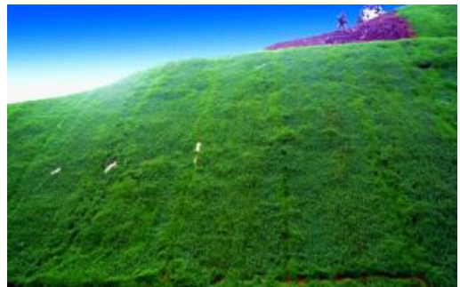
图 1.5-8 边坡三维网植被绿化成品
