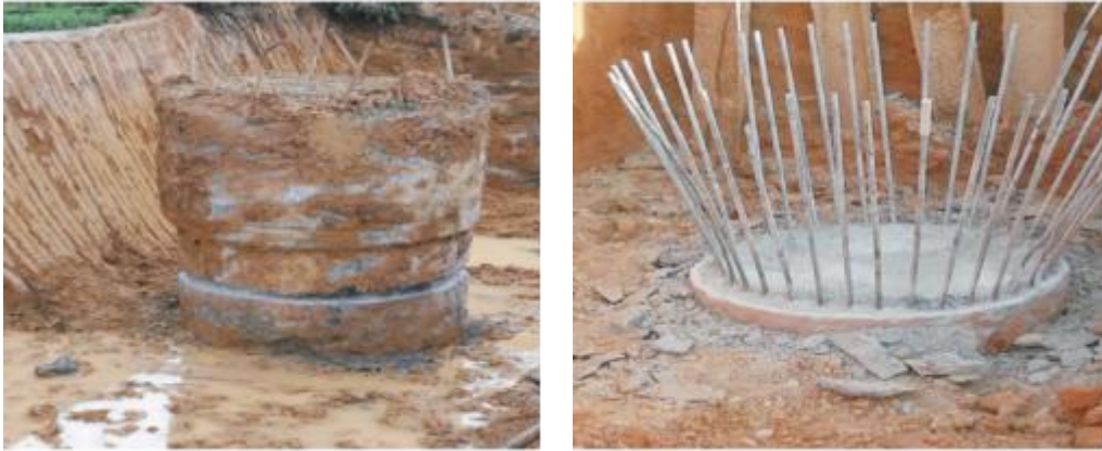
图 3.3.3 环切法破桩头
