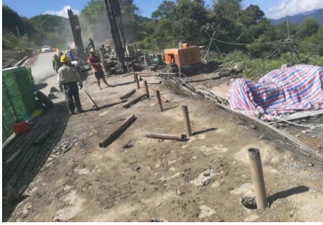
图 1.8-26 微型桩加固施工
