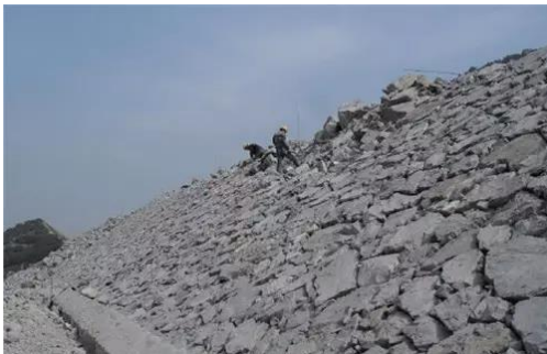
图 1.3-13 填石路基边坡码砌
