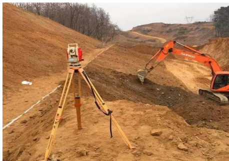
图 1.3-1 土质路堑开挖施工中
