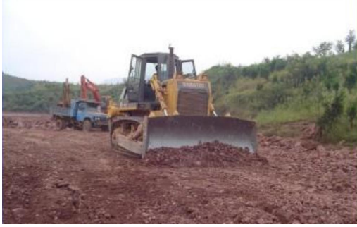
图 1.4-19 红砂岩路堤填摊铺
