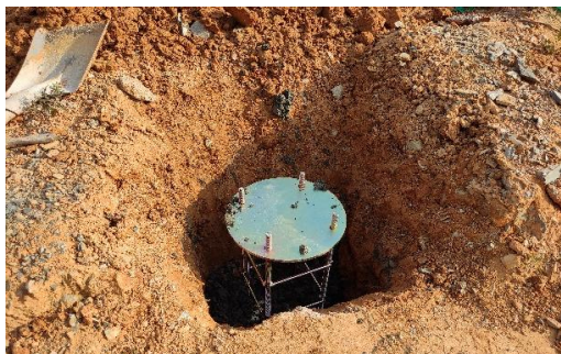
图 1.8-4 GNSS 设备安装
