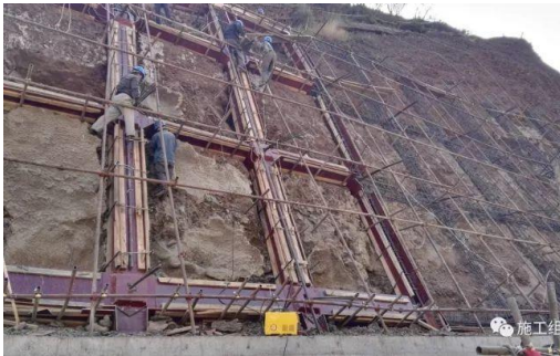
图 1.5-3 锚索框格梁护坡施工中
