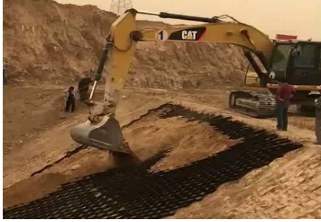
图 1.8-19 现场培土施工
