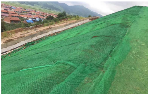
图 1.5-7 边坡三维网植被绿化施工
