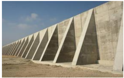
图 1.5-20 扶壁式挡土墙
