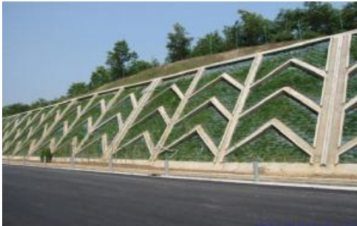
图 1.5-9 路堑植生袋边坡防护
