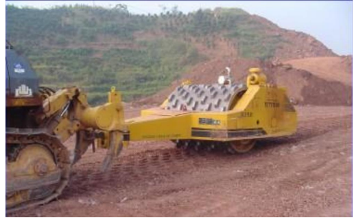
图 1.4-20 红砂岩路堤填碾压
