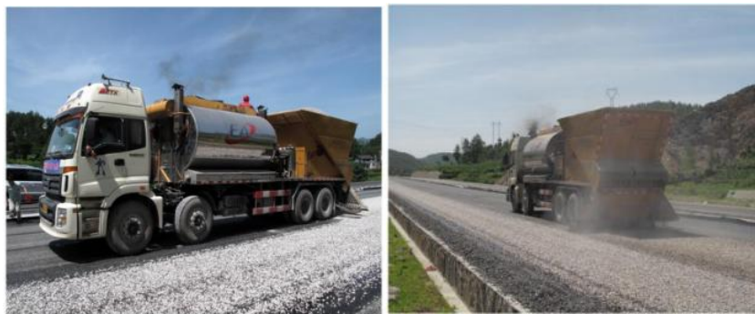
图 2.5.3 同步碎石封层施工
