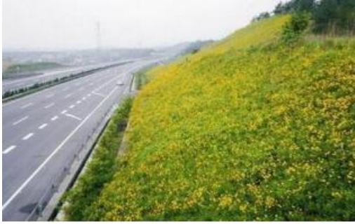
图 1.5-5 路堑边坡喷播防护
