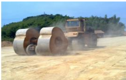
图 1.3-9 高填方路基冲击式压路机冲碾
