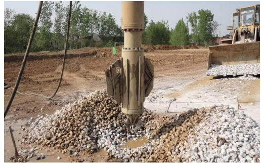
图 1.4-6 碎石桩施工
