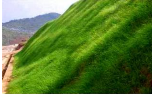
图 1.5-6 路堤边坡喷播防护
