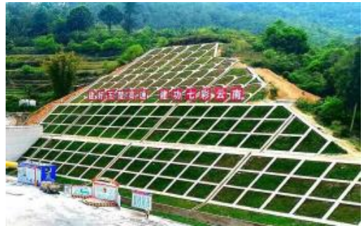
图 1.5-4 锚索框格梁护坡施工后
