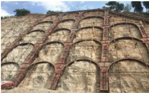
图 1.5-1 定型加盖钢模板
