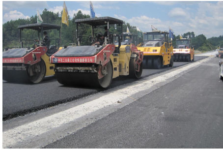
图 2.6-4 钢轮与胶轮压路机分组组合碾压
