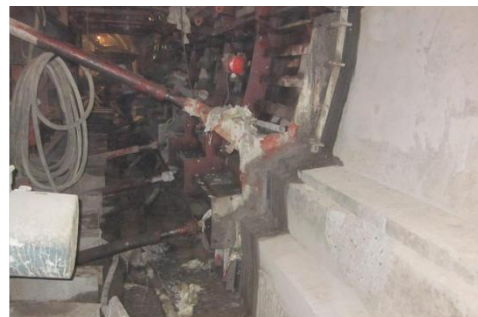
4.6-18 边墙及电缆槽模板
