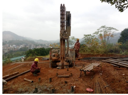
图 1.8-27 微型桩加固施工
