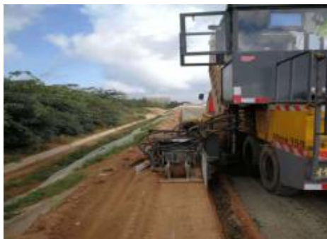
图 2.8-3 滑模施工土路肩
