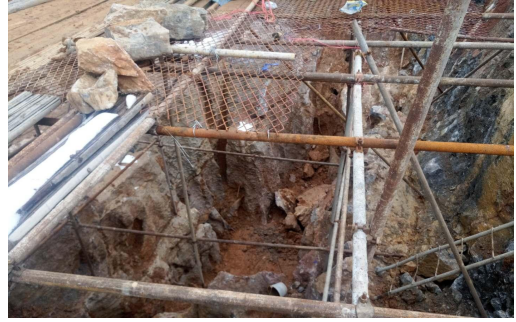
图 1.4-18 路基底部溶槽处治施工
