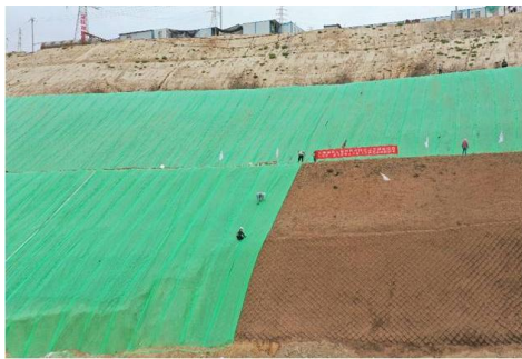
图 1.8-21 现场施工整体效果
