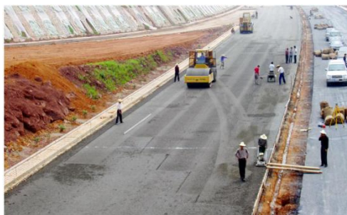
图 2.4-7 碾压图片（锯齿状端部与模板边部夯实）
