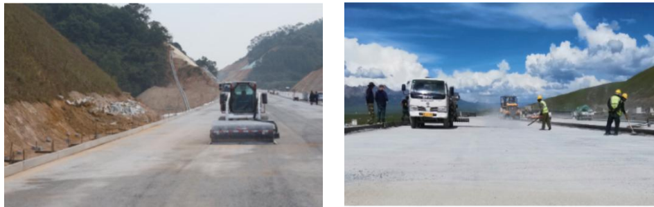
图 2.4-4 专用清扫机+人工辅助清扫工作面
