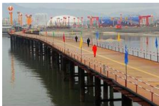
12.2-9 施工便桥防护标志
