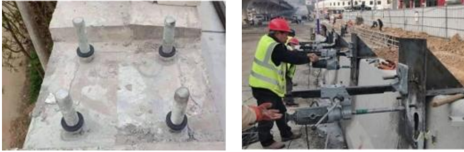
图 6.3-1 声屏障立柱与桥梁连接结构形式
