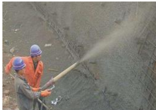
边坡（基坑）喷锚支护
