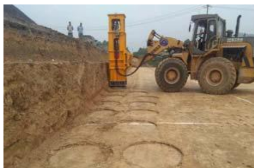
图 9.9-2 液压夯施工
