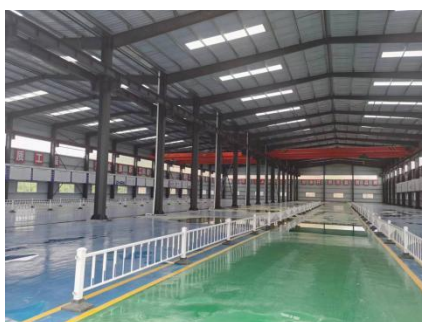
10.3.2-1 钢筋加工厂场地建设
