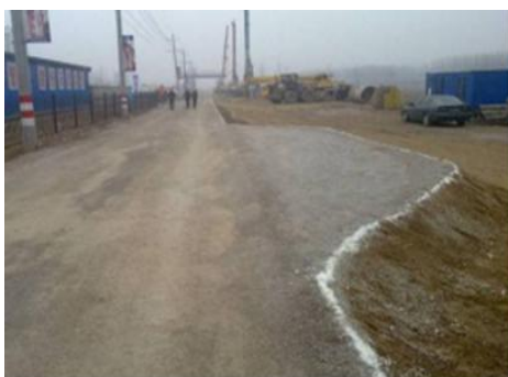
12.2-2 施工便道错车道
