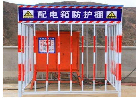
12. 4-4 配电箱防护棚
