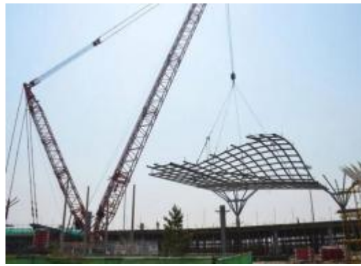
钢结构吊装示意图
