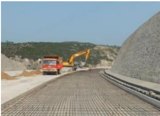
水泥混凝土路面施工
