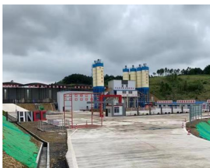
10.3.1-1 水泥混凝土拌合厂
