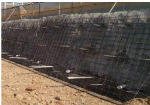
边坡（基坑）喷锚支护
