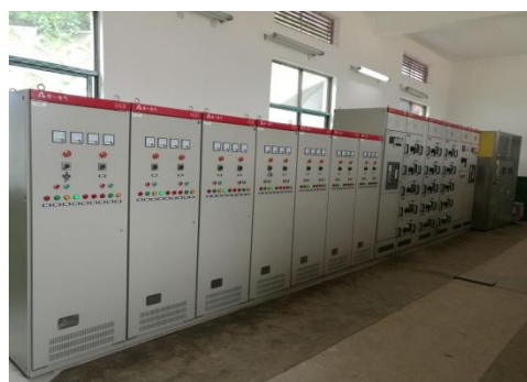
7.6.3-2 低压柜和变压器
