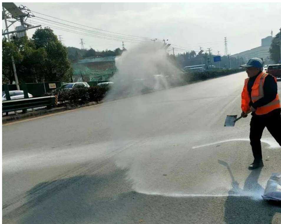
△一线养护人员上路开展预防性防冰冻作业，在桥梁部位撒融雪剂
