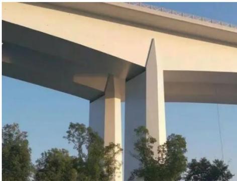
3.1.3-5 突出线条轮廓的桥墩造型
