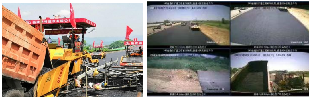
图 5.4 摊铺智能管控
